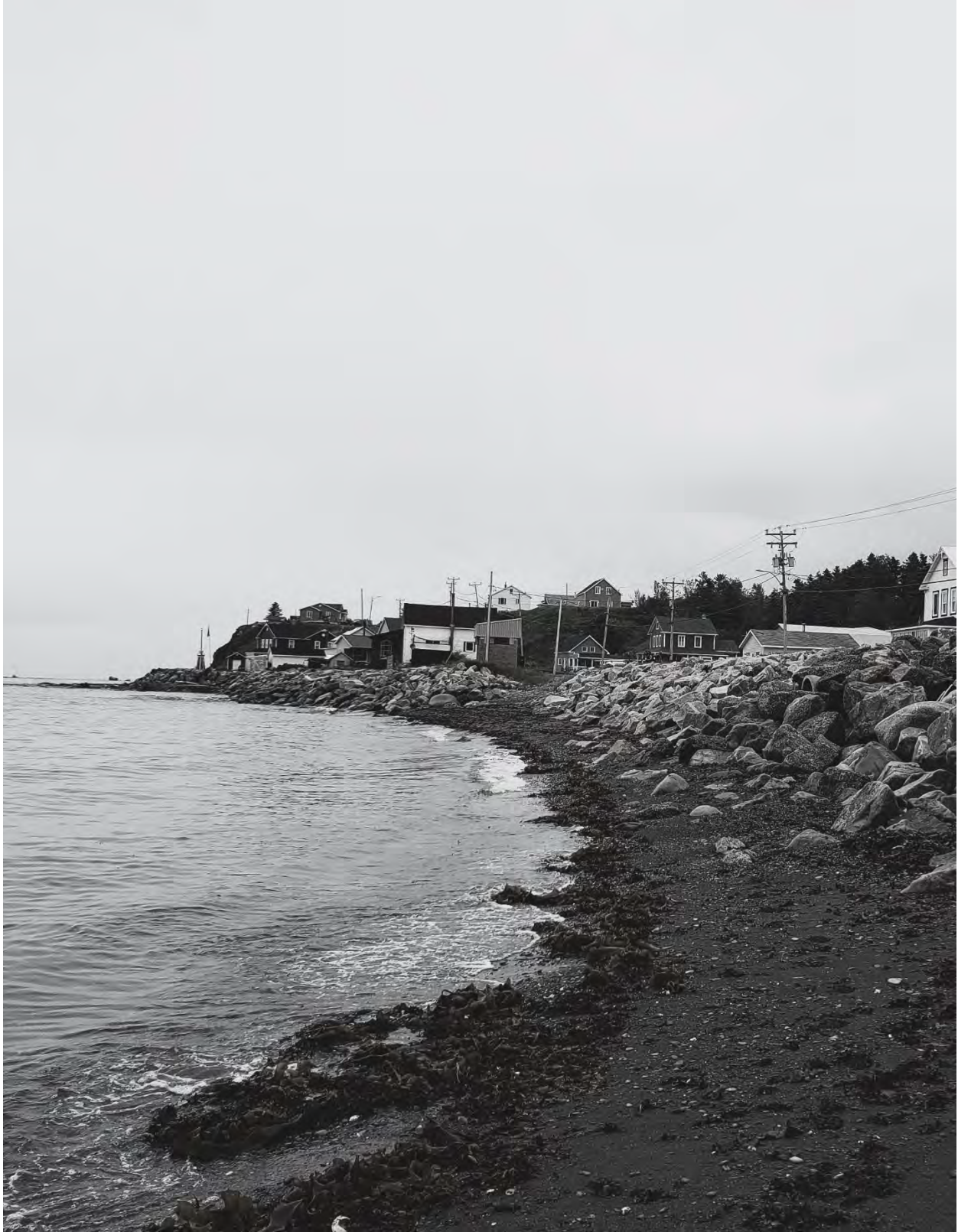
Figure 1. Enrochement à l'est de la municipalité de Les Méchins en Matanie (Source : Auteure, 2021) Cette méthode de protection des berges vise à protéger les habitations de l'érosion.
