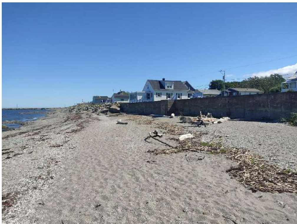
Image 10 : Muret et enrochement au niveau du centre urbain
