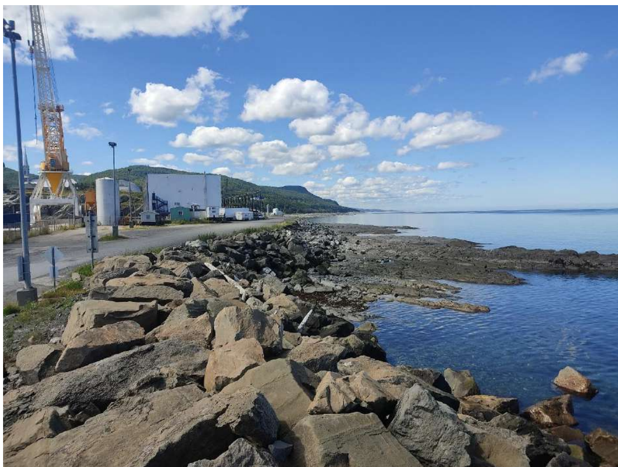
Image 15 : Enrochement protégeant le secteur portuaire du village (Photo prise le 9 août 2022)
