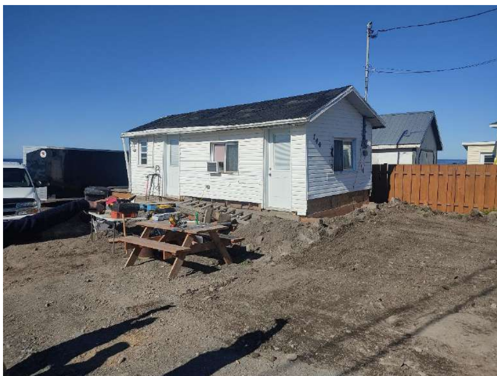
Image 13 : Surélévation d'une maison face au risque de submersion (Photo prise le 8 août 2022)
