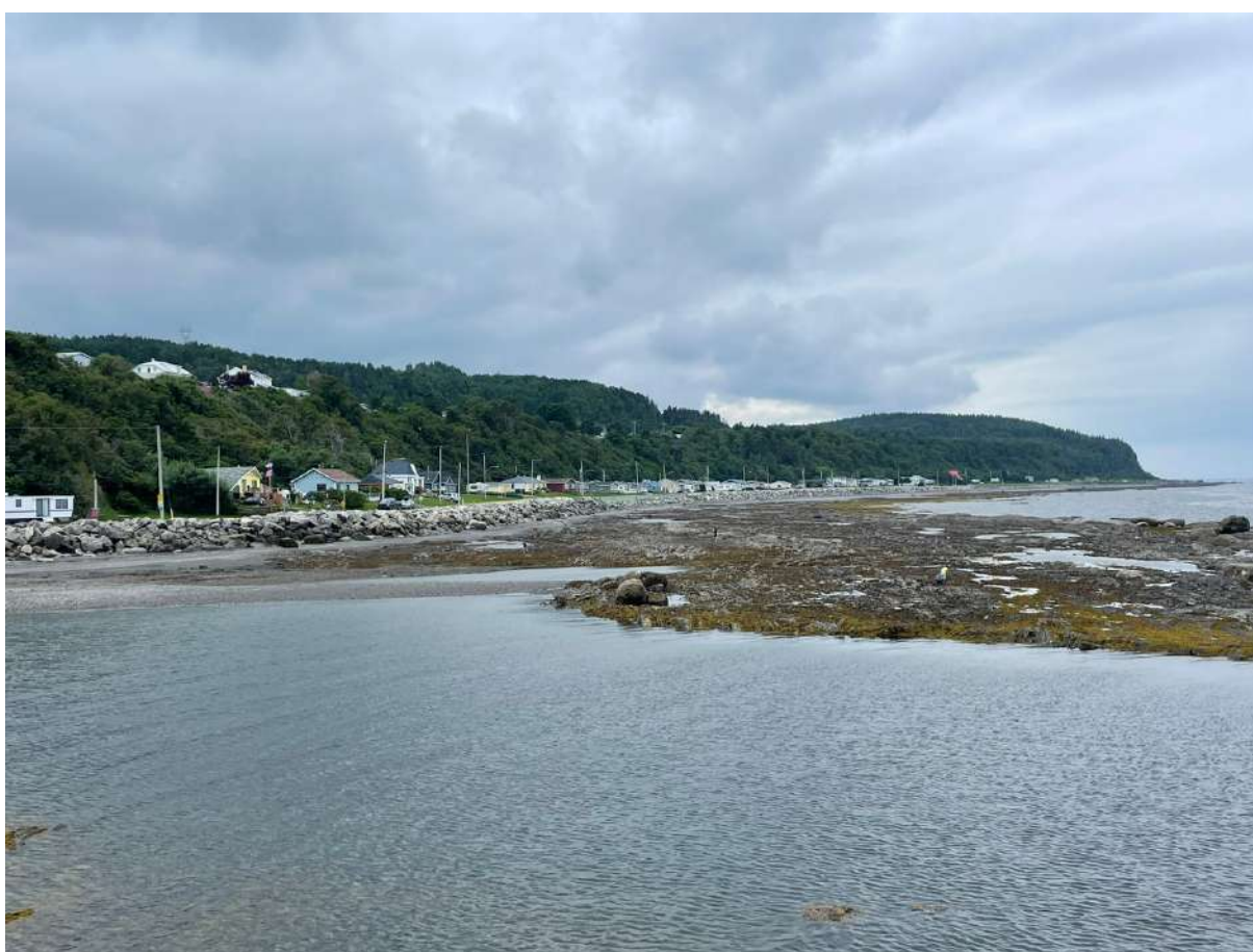
Image 14 : Enrochement de l'Anse au Foin, Grosses-Roche (Photo prise le 9 août 2022)
